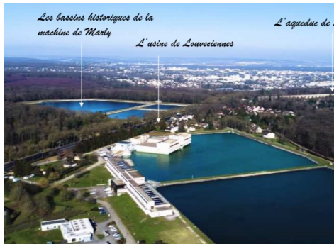
Usine de Louveciennes
