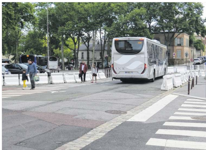
Le carrefour formé par l'avenue de Sceaux et la place des Francine sera sans doute l'un des nœuds de circulation du projet.
