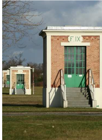
Un ensemble de 40 forages dans la plaine du Pecq Croissy, situés en bordure de la Seine permettant l'extraction de plus de 100 000 m 3 / jour
