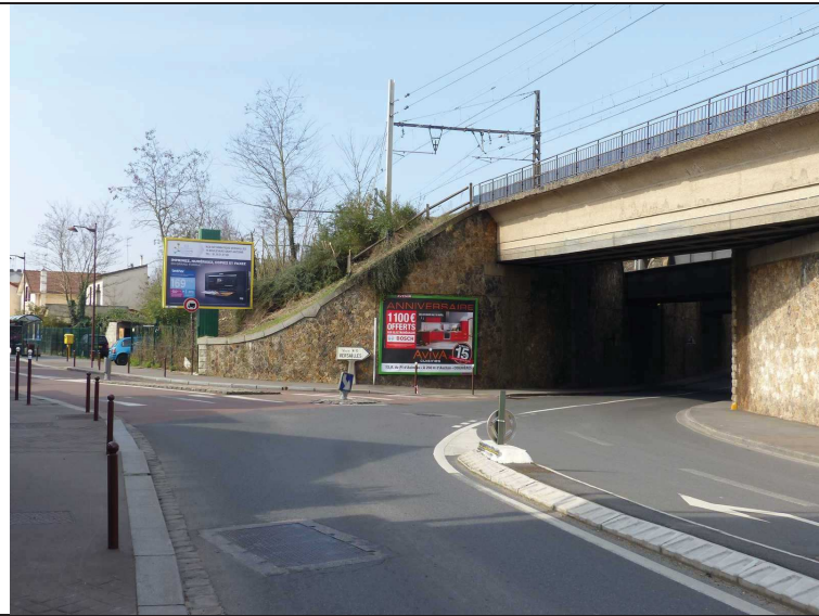
Les six ponts vue de sortie Viroflay
