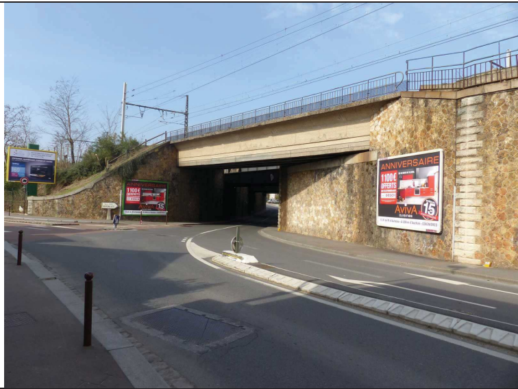
Les « six ponts » vue de Av. de Versailles
