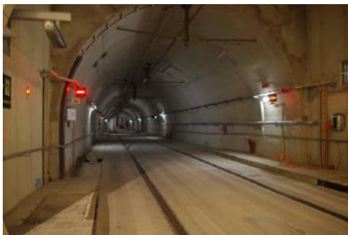
Tunnel d'arrière gare – A noter l'aiguillage qui permet le retournement de la rame
