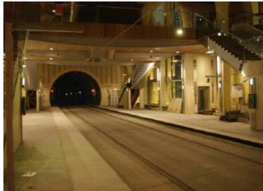
Vue du tunnel d'arrière gare depuis la station
