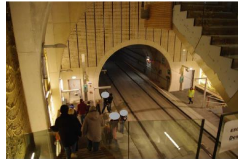
Mezzanine intermédiaire A droite, escalier additionnel
