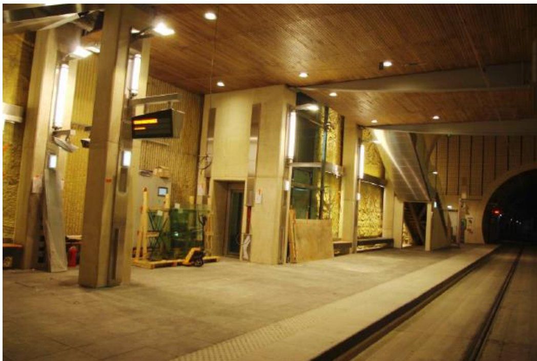
Vue de la station côté tunnel arrière gare – Quai « départ »
