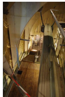
Vue vers l'arrière de la station
