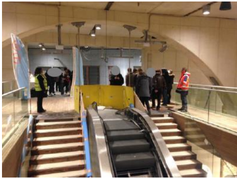
Accès aux quais du tramway niveau mezzanine supérieure supérieure
