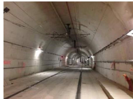
Tunnel d'arrière gare – A noter l'aiguillage qui permet le retournement de la rame
