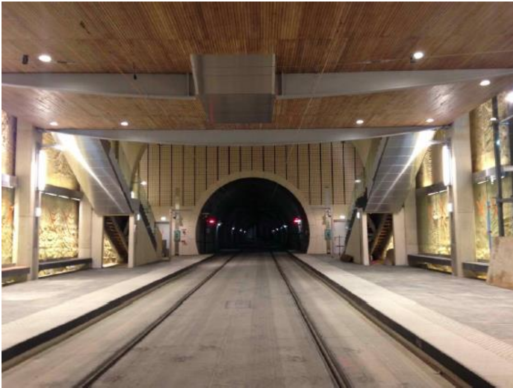
Vue de la station côté tunnel de circulation
