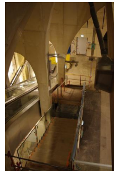
Vue vers la tête de station
