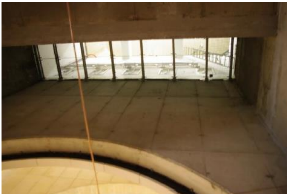
Grille de ventilation située au-dessus de l'entrée du tunnel d'arrière gare
